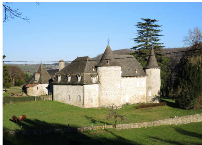
Le château d'Entraygues à Boisset
